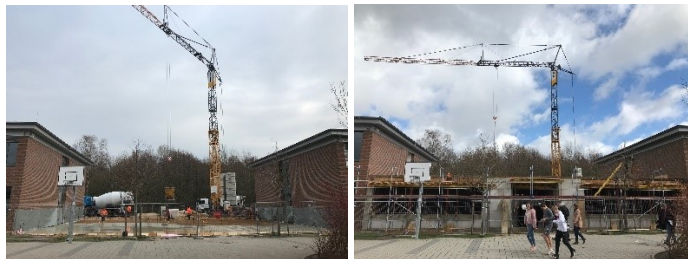
Der Anbau entsteht: Februar und März 2019
